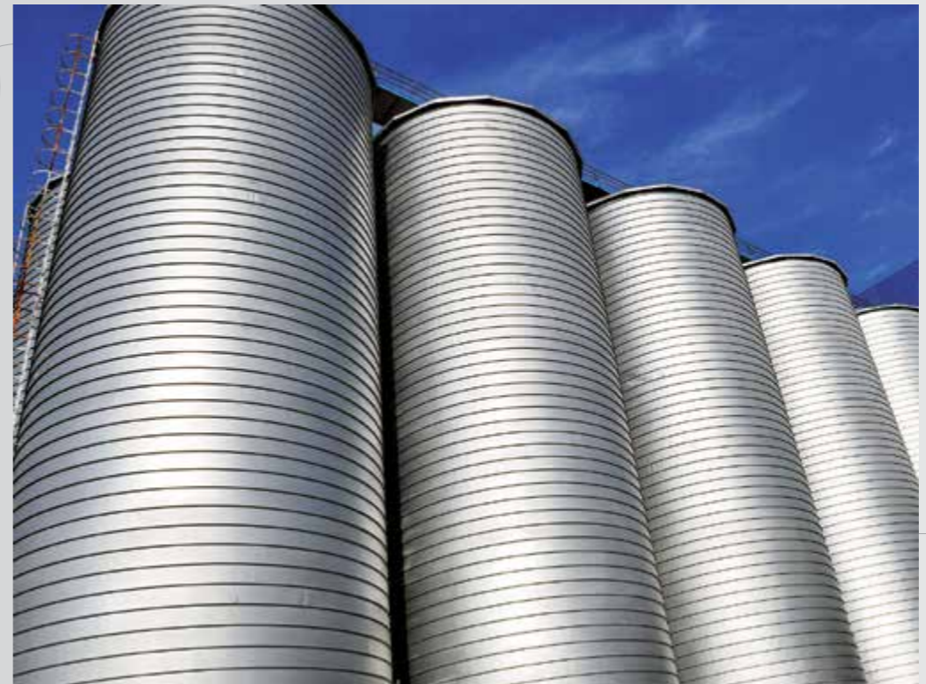
PROJEKT: SANÁCIA SILA, DERVENTA INVESTOR A ZHOTOVITEĽ: "POLJPRIVREDNIK AD", DERVENTA
