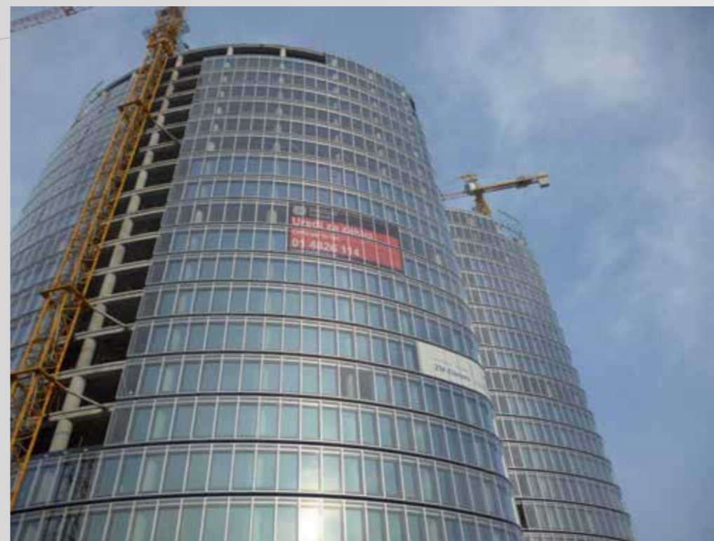
PROJEKT: SKY OFFICE, ZAGREB IZVAJALEC: "OIP" (ODRŽVANJE I IZGRADNJA POGONA)
