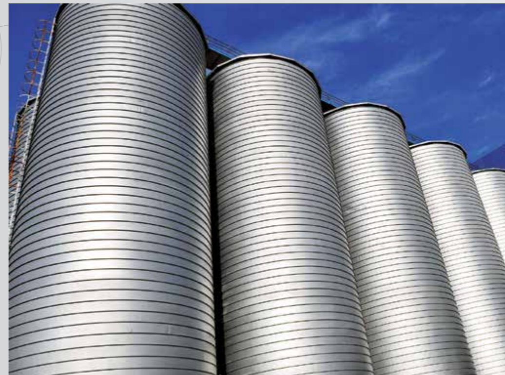
PROJEKT: SANACIJA SILOSOV, DERVENTA INVESTITOR IN IZVAJALEC: "POLJPRIVREDNIK AD", DERVENTA
