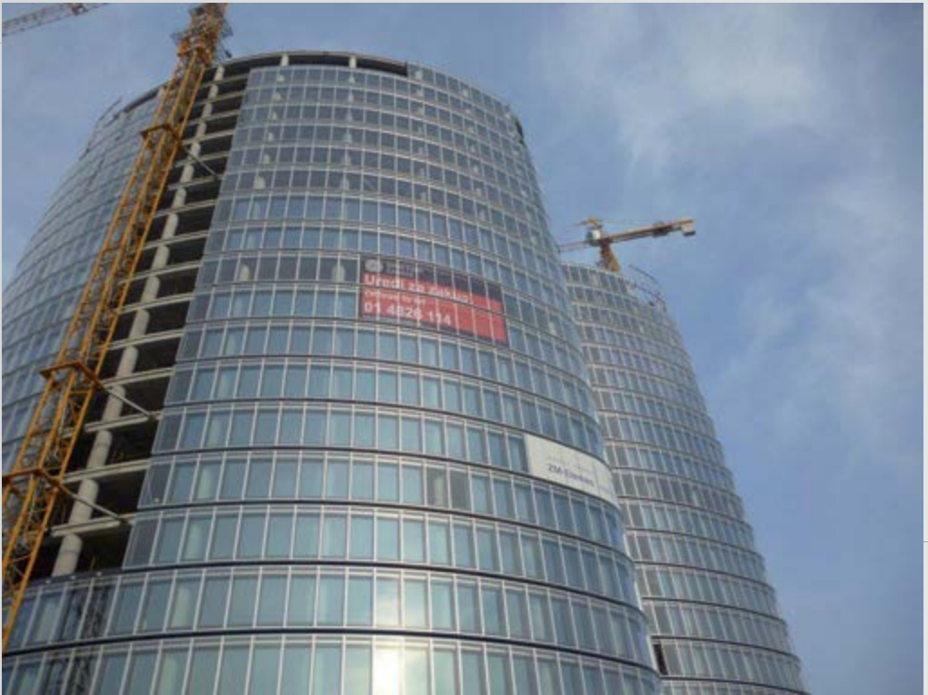
ПРОЕКТ: SKY ОФИС ЗАГРЕБ ПОДРЯДЧИК: "OIP" (ТЕХНИЧЕСКОЕ ОБСЛУЖИВАНИЕ И СТРОИТЕЛЬСТВО ОБЪЕКТА)
